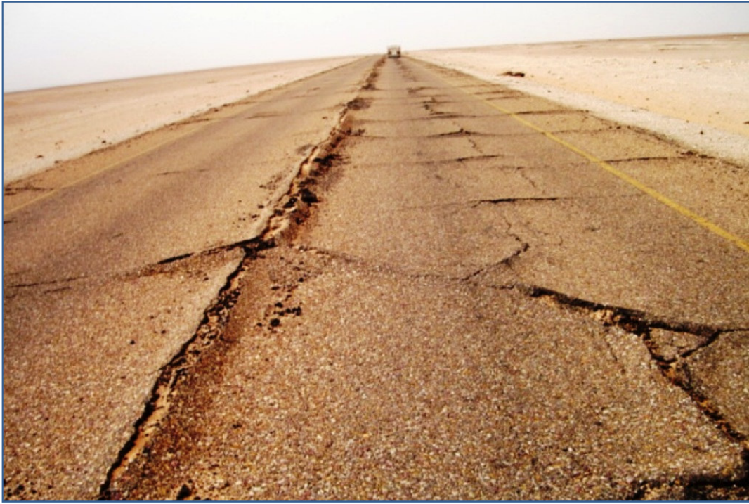
شكل 5.3: ترسب الرمل في الشقوق وتكون الحواف المرتفعة (الاعتاب)
